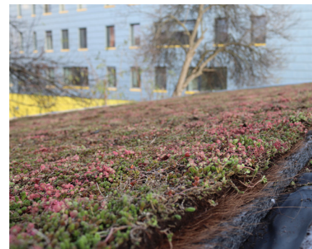
Extenzivní zelená střecha v areálu Otevřené zahrady (Zdroj: Archiv Nadace Partnerství)
