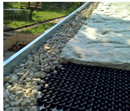
Lehká skladba zelené střeš nad venkovní kuchyní Urbanscape od firmy Knauf Insulation, na které je položený rozhodníkový koberec od firmy Sedum Top. (Zdroj: Archiv Nadace Partnerství)
