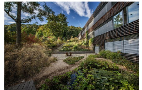
Kořenová čistírna v Otevřené zahradě nejen čistí odpadní vodu, ale také přirozeným výparem v létě ochlazuje své okolí a zpřjemňuje prostředí po estetické stránce. (Zdroj: Aliance pro energetickou soběstačnost)
