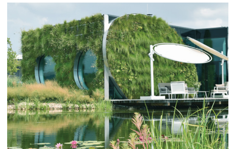
Firma LIKO-S testuje na své budově LIKO-Noe fasádní vegetační kořenové čistírny, které najdou své uplatnění ve městech i v průmyslových areálech. (Zdroj: zivestavby.cz)
