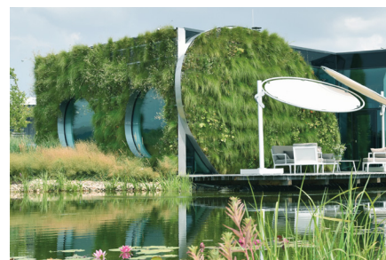
Firma LIKO–S testuje na své budově LIKO–Noe fasádní vegetační kořenové čistírny, které najdou své uplatnění ve městech i v průmyslových areálech. (Zdroj: zivestavby.cz)
