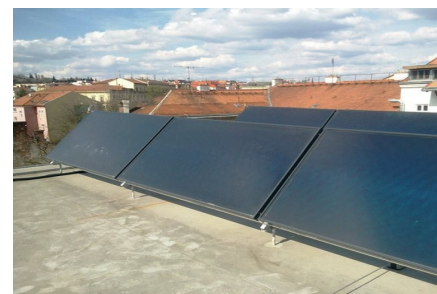
Solární kolektory v areálu Otevřené zahrady s letních měsících dokážou pokrýt až 100 % nákladů na ohřev teplé užitkové vody. (Zdroj: Archiv Nadace Partnerství)
