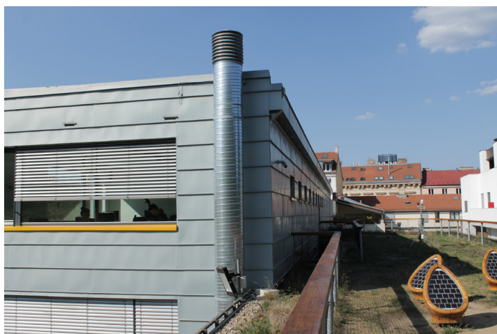
Vydýchaný vzduch odvádíme pryč z budovy komínem. (Zdroj: Aliance pro energetickou soběstačnost)
