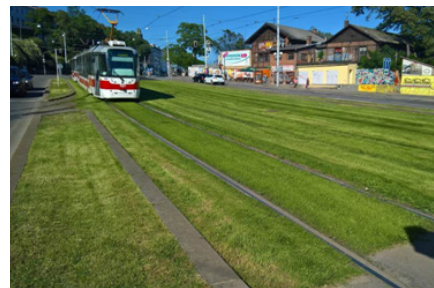
Travnatý tramvajový pás na ulici Nové sady v Brně. (Zdroj: Archiv Nadace Partnerství)
