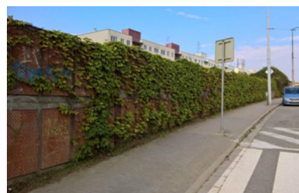
Zed' porostlá popínavou rostlinou na ulici Oblá v Brně ochlazuje prostředí a zároveň tlumí hluk. (Zdroj: Archiv Nadace Partnerství)
