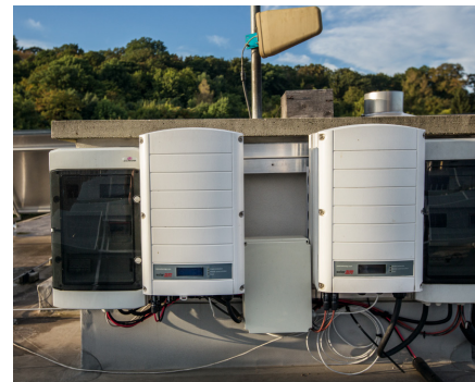
Měnič napětí neboli střídač slouží k přeměně stejnosměrného napětí na střídavé. (Zdroj: Aliance pro energetickou soběstačnost)
